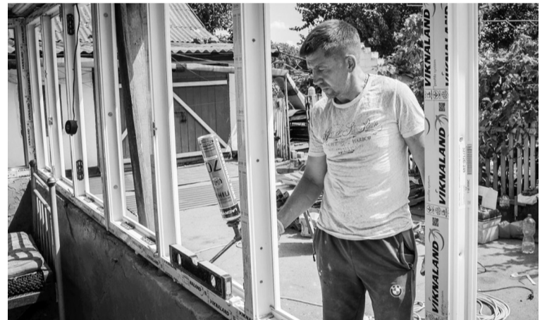
Будівельні роботи ведуться в режимі нон-стоп.
