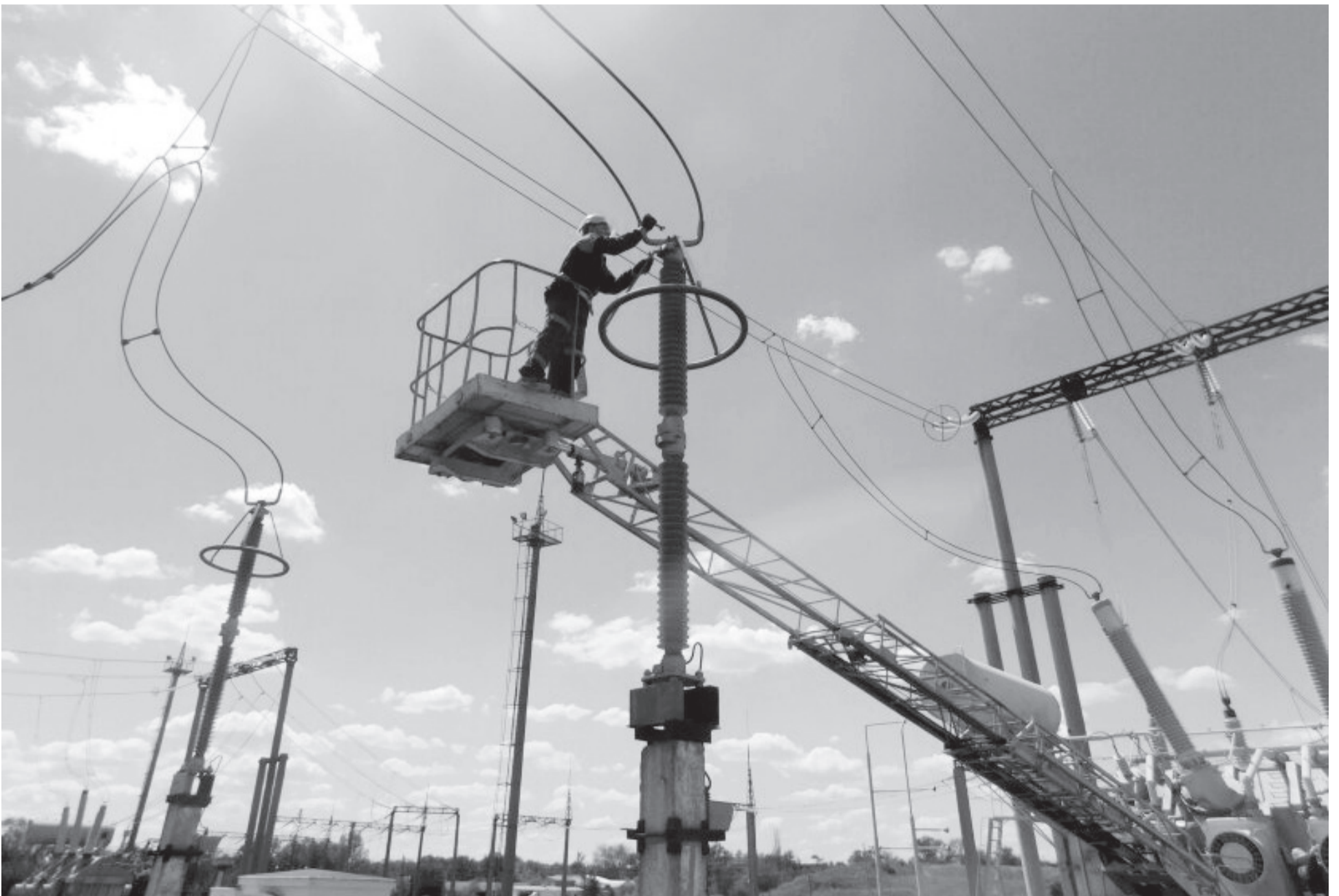
Ремонтні бригади відновлюють повітряні лінії електропередач після ракетних ударів окупантами. Фото з сайту hvulya.net.
